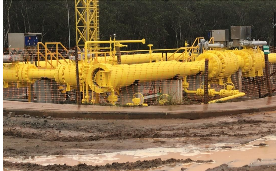
Inertização de dutos - Petrobras.
